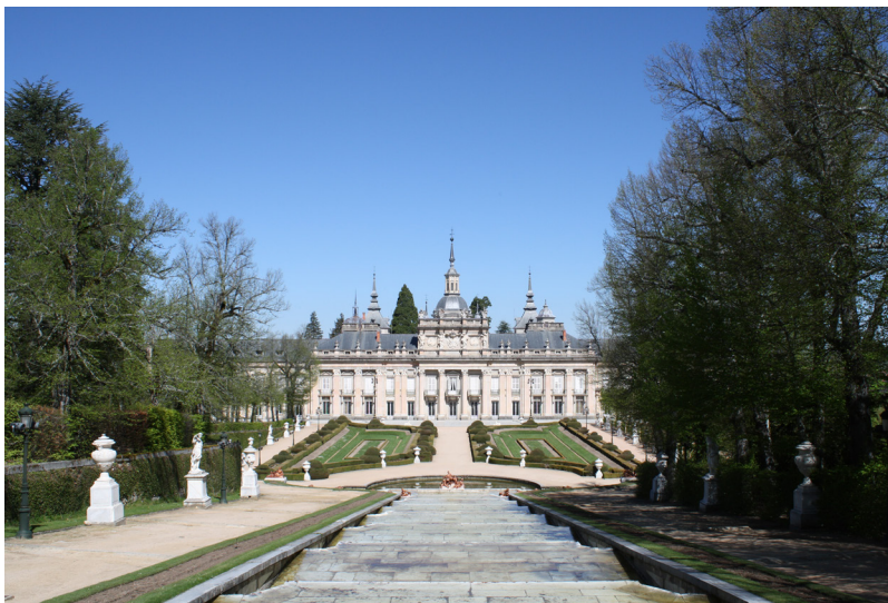
Figura 25. Fachada sur del palacio real
