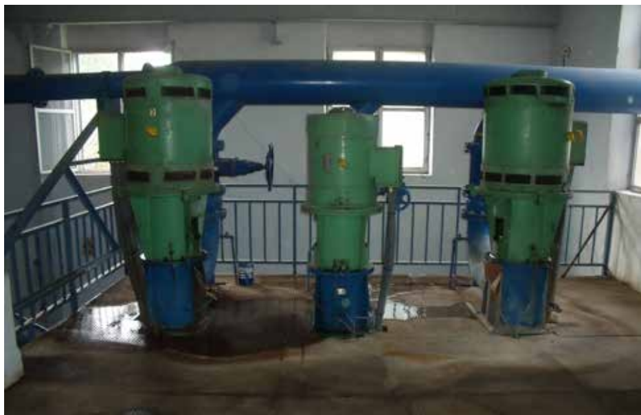
Figura 9. Motores de la Comunidad de Regantes «Motor Resurrección», que elevan aguas del Segura desde la Acequia Principal de Abarán (Murcia) en la margen izquierda del río. Fuente: autores (29-10- 2016).
