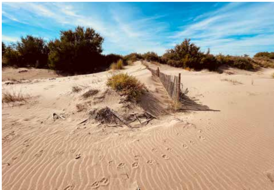
Figura 6. Trampas de arena ubicadas en la playa de Sant Pere Pesador en marzo de 2023. Al fondo de la imagen se observa la contraduna elevada artificialmente hace 150 años y convertida, con el paso de los años, en una foredune . Fotografía: Carla Garcia-Lozano (2021).
