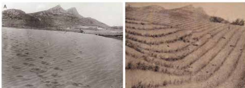
Figura 4. Campos dunares de la vertiente sur del Montgrí antes (A) y después (B) de los trabajos de fijación dunar con Ammophila arenaria . Autores y fechas desconocidos. Fuente: Archivo municipal de Torroella de Montgrí.
