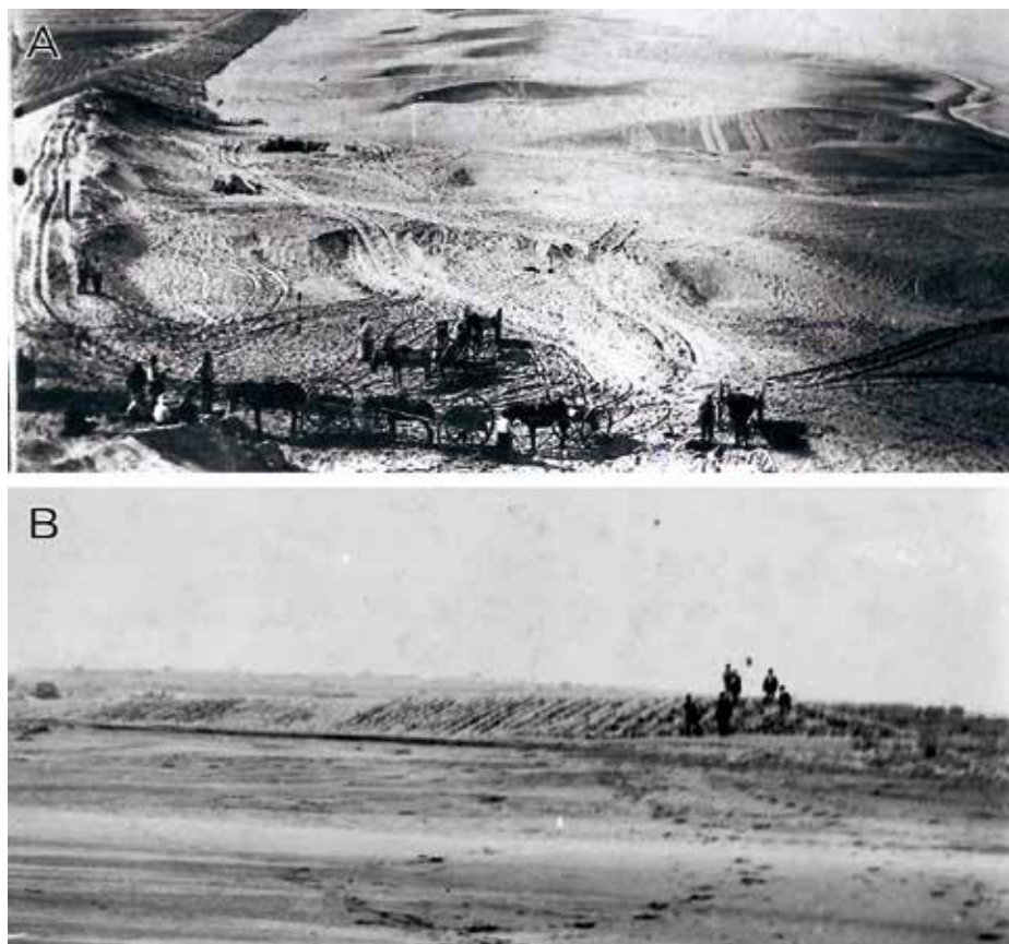
Figura 3. Construcción de la contraduna (A) y trabajos de fijación con Ammophila arenaria (B) cerca de St. Martí d'Empúries en algún momento entre 1896 y 1910. Autores desconocidos. Fuente: Fondo Josep Esquirol.
