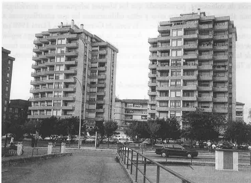
Foto 19. Bloques del Grupo Guillermo Arce de 356 viviendas promovidas entre 1970 y 1974 por Francisco Revilla. La agrupación de edificabilidad está presente.
