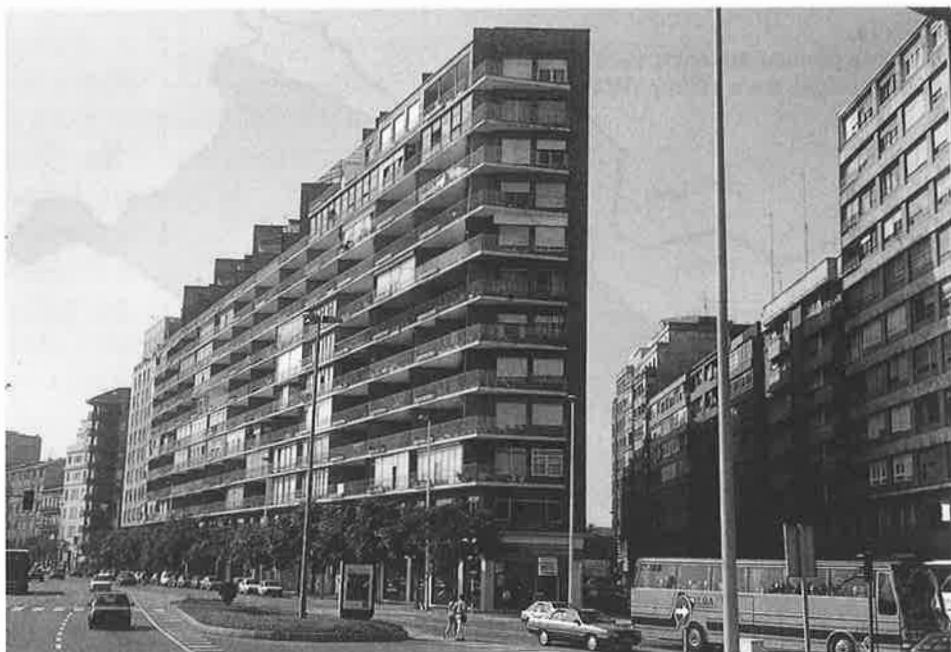
Foto 1. Edificio de 160 viviendas promovido por Feygón en 1959. Viviendas de calidad para sectores mesocráticos.
