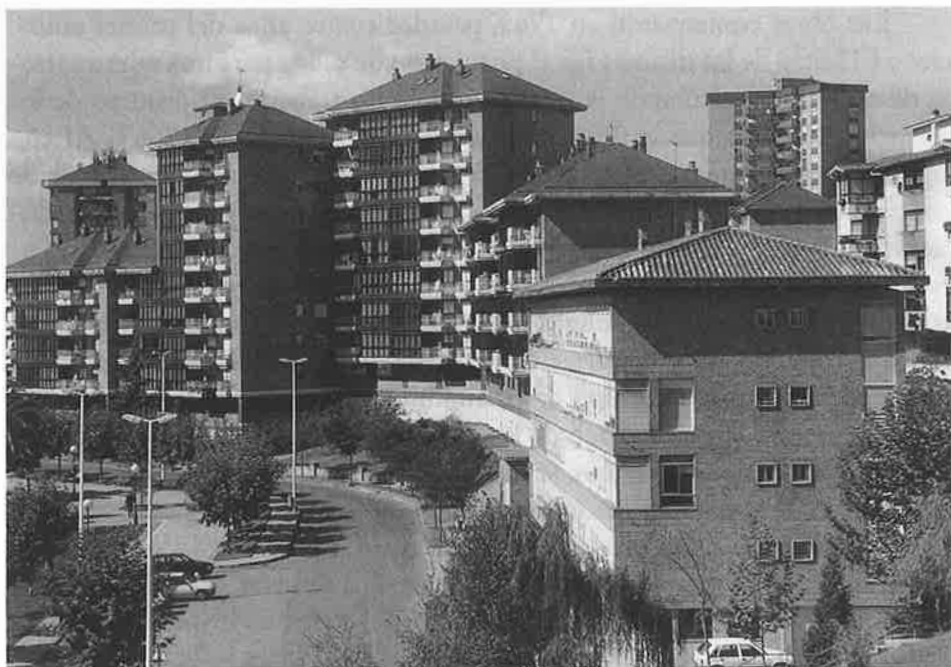
Foto 21. Bloques de la promoción tutelada en el sector meridional del polígono de Cazoña.
