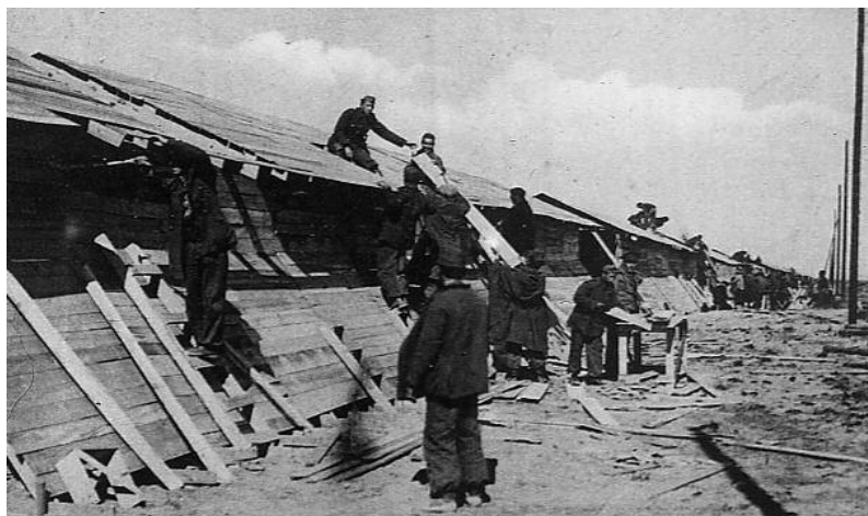
Campo de Bacarès. Construcción de barracas destinadas a los refugiados (Col. Samot).
