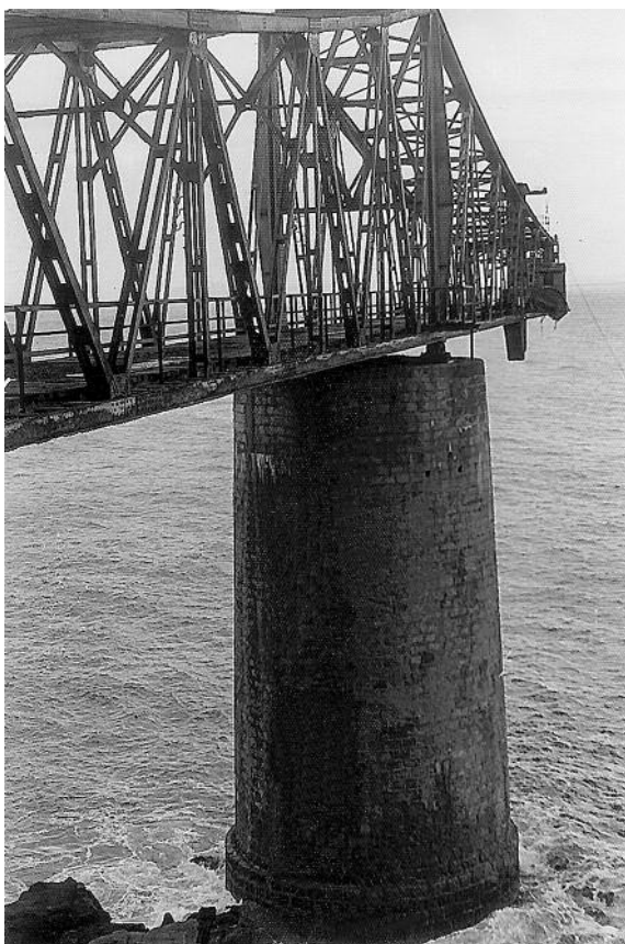
Cargadero de mineral de Dícido, Castro Urdiales.
