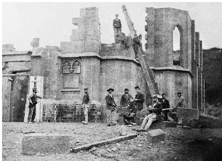
La capilla-panteón durante su construcción, 1880-1881, Comillas.
