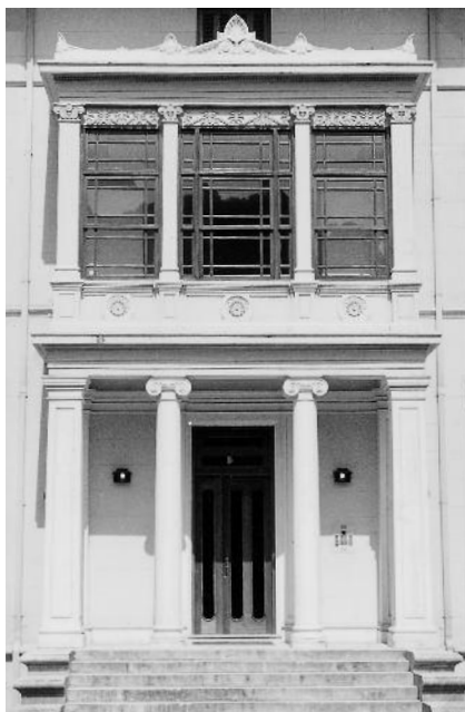
Portal neogriego en la Avenida de los Infantes, El Sardinero.
