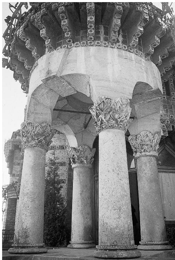
El Capricho, columnas de la torre-pórtico, Comillas.
